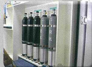
ボンベ庫増設
